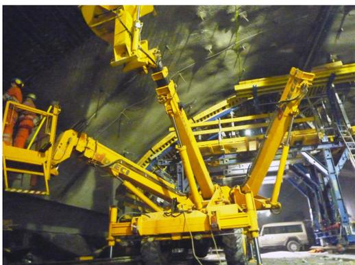
La presenza delle tre braccia permette di ottimizzare notevolmente i tempi, velocizzando gli interventi all'interno dei tunnel anche ad altezze molto elevate:
